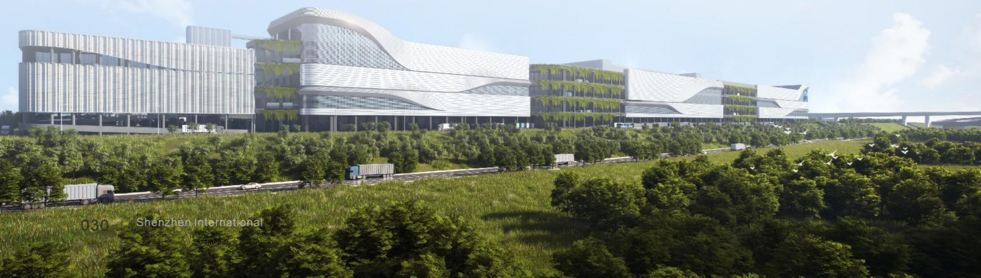
深圳国际综合物流枢纽中心
