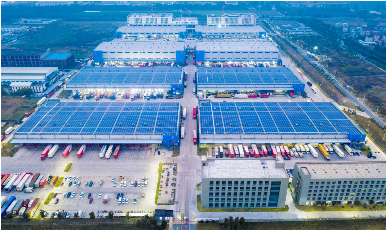
深国际物流港 | 杭州 · 项目屋顶光伏
