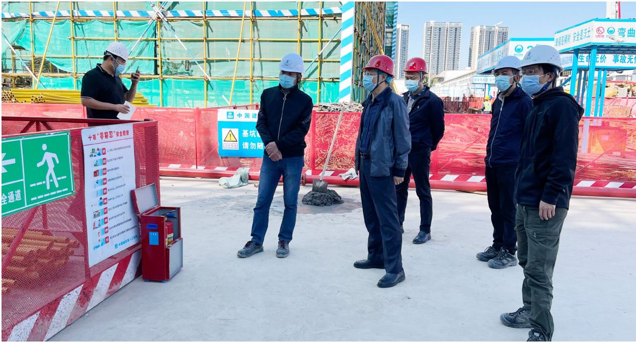
2022 年 5 月，深国际开展前海二期项目安全检查
